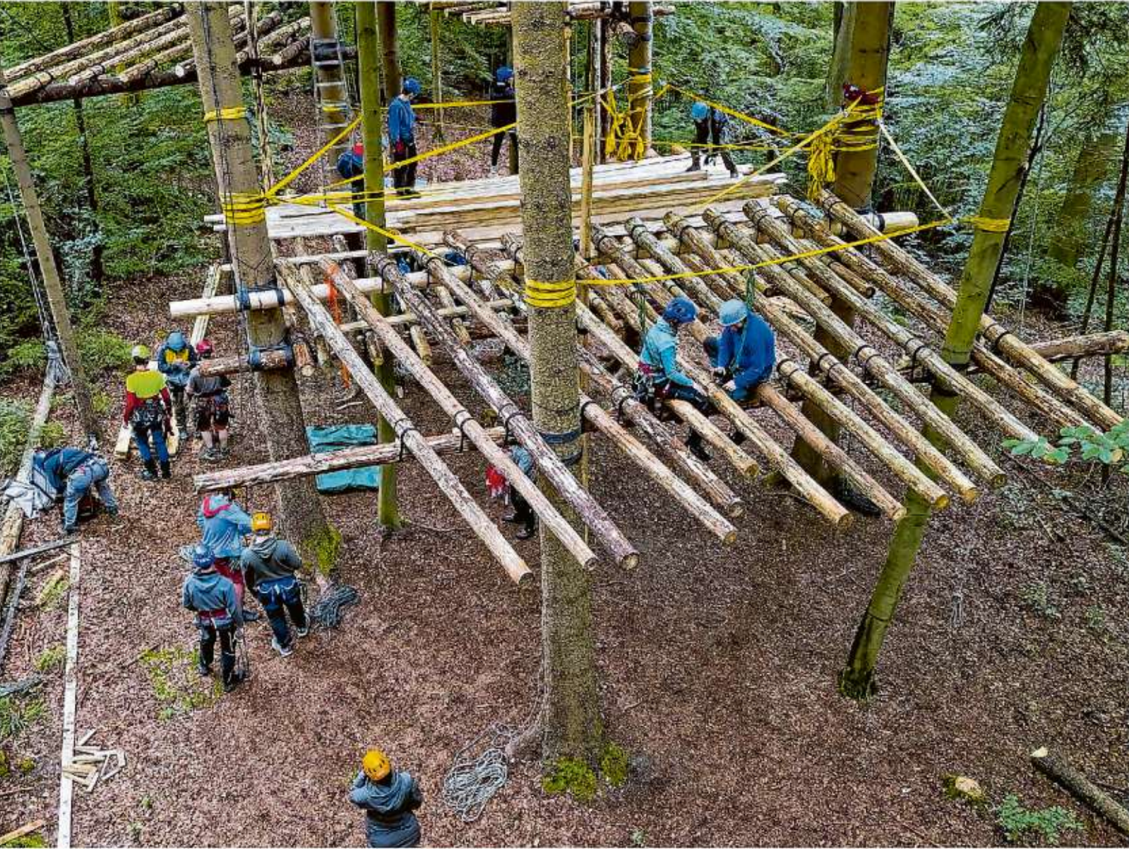
Fest verbunden mit Bäumen werden die Träger der Plattformen montiert. Bei der Arbeit wird stets auf Sicherheit geachtet. Gefährliche Werkzeuge wie Motorsägen werden zum Beispiel nur von ausgebildeten Fachleuten bedient. Fotos: Wolfgang Pfister
